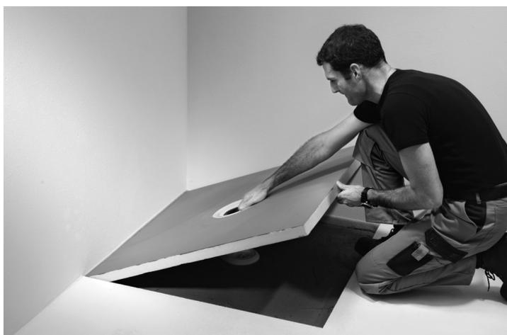
Placez fermement JACKOBOARD Aqua sur le mortier en s'assurant de sa bonne mise en place par rapport au siphon (le siphon doit être au centre du joint).
