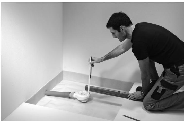
La distance nécessaire entre le niveau de la chape et le bord supérieur du siphon dépend des dimensions du receveur (voir tableau „Hauteurs utiles“). Le siphon doit être positionné de manière à respecter cette distance.
